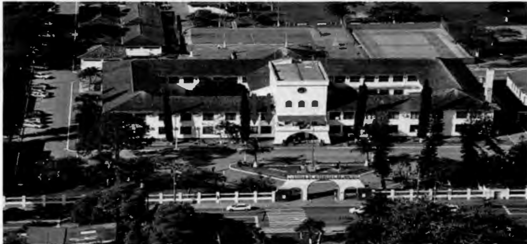
Figura 01 – Vista geral da Escola de Aprendizes Marinheiros de Santa Catarina, com setas indicativas para a localização da suíte examinada. Fonte: Google Earth.
